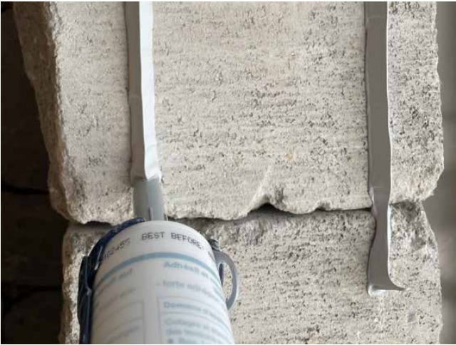
Illustration 3 : Positionnement correct de la buse
