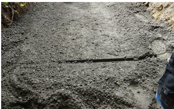
Bild 23: Erstellen des Streifenfundamentes
