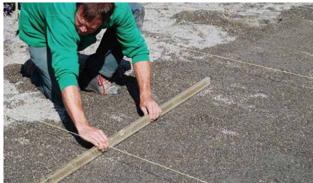
Nivellement du lit de pose
