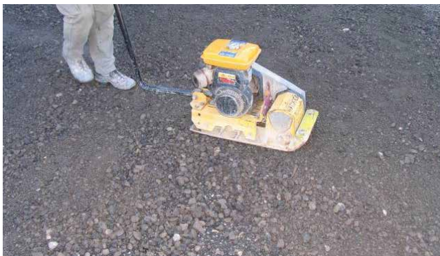
Compactage de la couche de fondation
