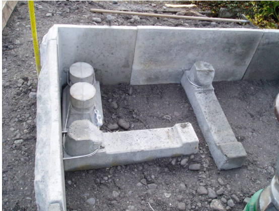
Bild 39: Eckstein mit Eckanker und -spanner
