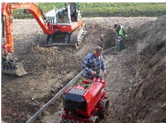
Bild 21: Verdichten mit Schaffusswalze
