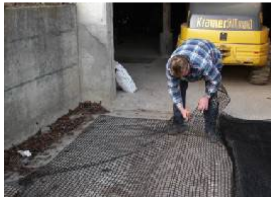
Bild 23: Ablängen der Geogitter
