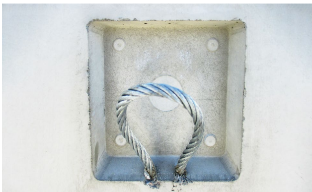
Bild 18: Werkseitig eingebaute Seilschlaufen
