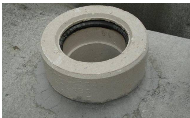
Bild 1: CENTUB® Klebeanschlussstück 90° eingebaut
