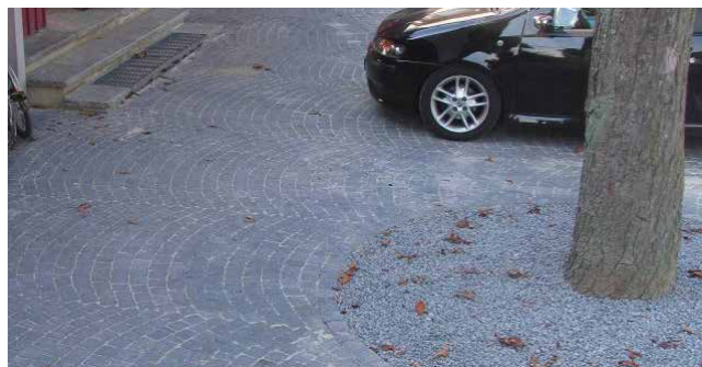
Adaptation à une ouverture pour un arbre
