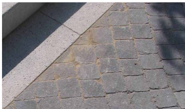
Surface pavée avec pierres d'ajustage
