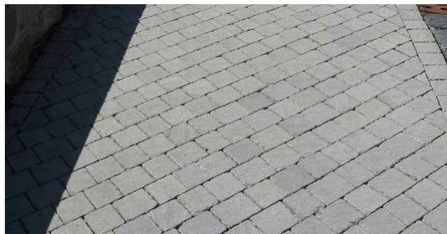
Surface pavée avec pierres d'ajustage en cas de bordure
