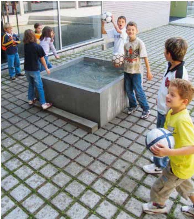
Pausenplatz mit Rasenfugenstein
