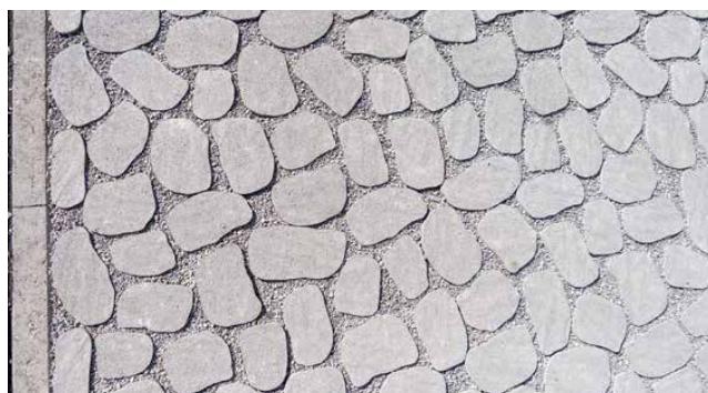
Illustration 2 : pavés de bord posés le long des pavés-gazon
