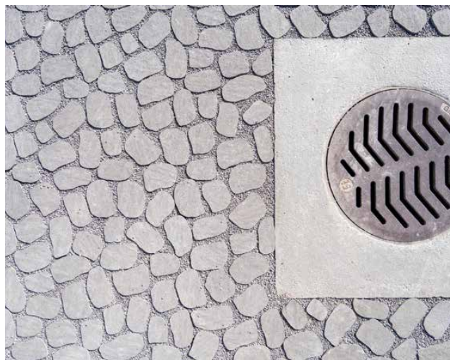
Illustration 3 : avaloir avec collerette en béton
