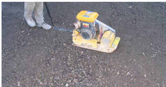
Illustration 4 : compactage de la couche de fondation
