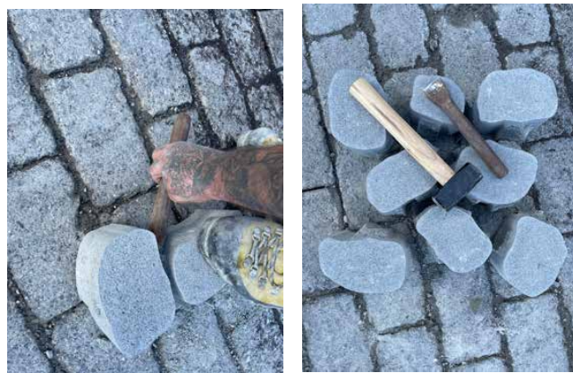
Illustration 9 : séparation en morceaux à l'aide d'un marteau et d'un burin
