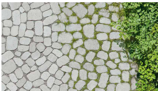
Illustration 7 : remplissage des joints – gravillons et végétalisation
