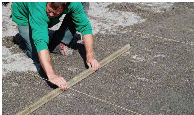
Illustration 5 : nivellement du lit de pose
