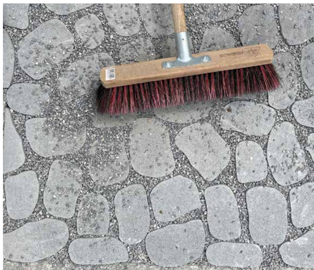
Illustration 6 : sablage des joints
