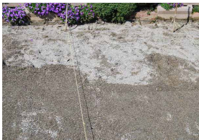
Cordeau pour l'alignement, la direction ou pour la réalisation de la trame
