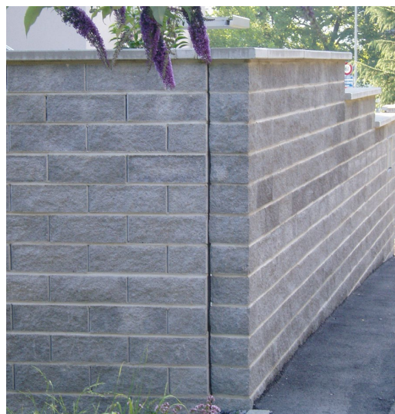
Bild 41: Dilatationsfuge (Produktneutral)
