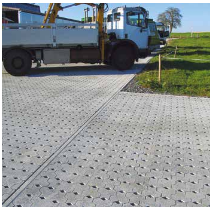
Parkfläche mit SIX SILENTA Ökostein (Splittfugen)
