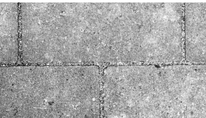
Wirksame Pflasterdecke durch funktionsfähige Fugen
