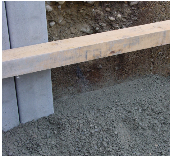
Bild 7: Vorbereitete Sohle mit Richtlatte
