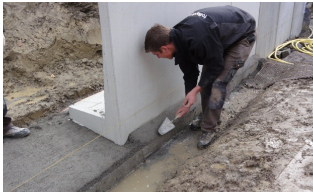
Bild 37: Erstellen der Fundamentnocken
