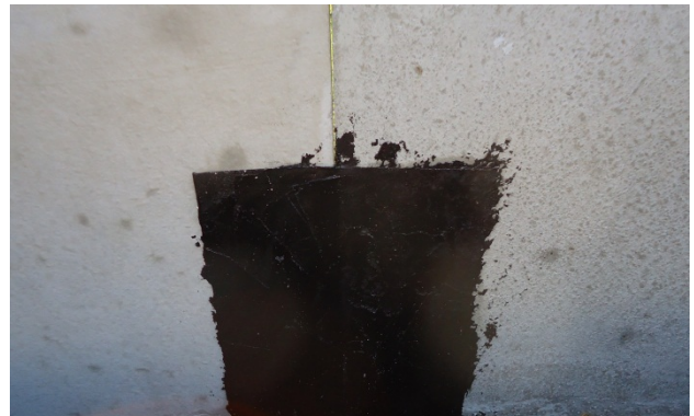
Bild 33: Abdichten der Fugen
