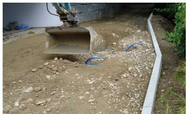
Bild 34: Lagenweises Einbringen von geeigneten Hinterfüllmaterial
