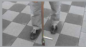
FERS ALIGNEURS POUR PAVÉS CLASSIQUES ET AUTOBLOQUANTS
