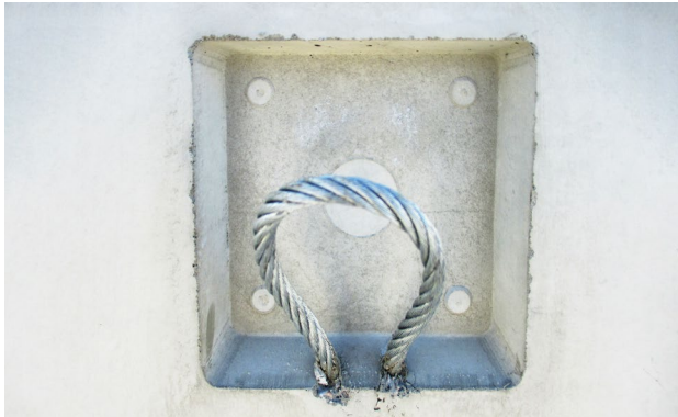
Bild 18: Werkseitig eingebaute Seilschlaufen
