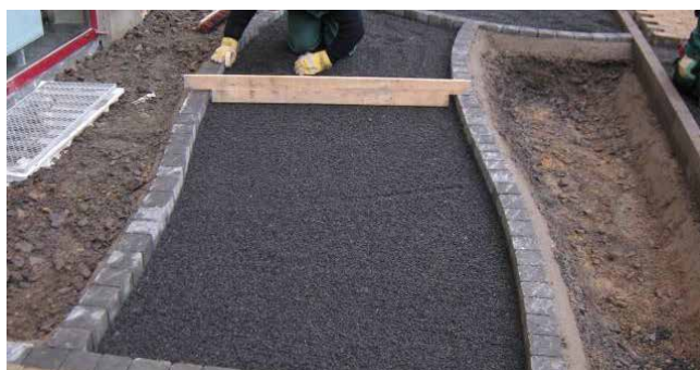
Bordures latérales en pavés bétonnés
