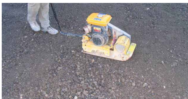
Compaction de la couche de fondation
