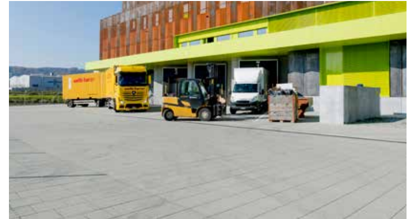
VS 5® Schwerlastpflastersteine mit 5-facher Verschiebesicherung in Grau - Englisch verlegt
