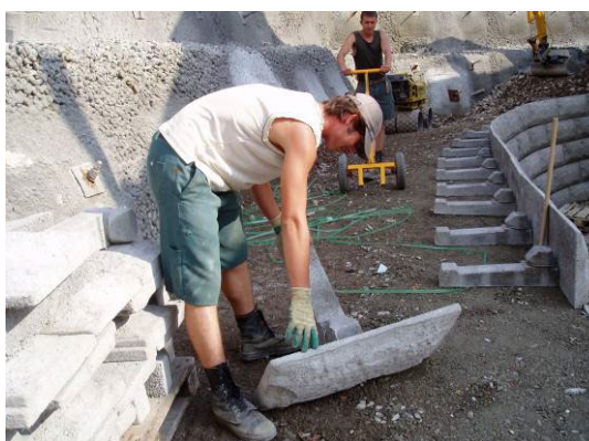
Bild 16: Frontplatte mit Anker verbinden
