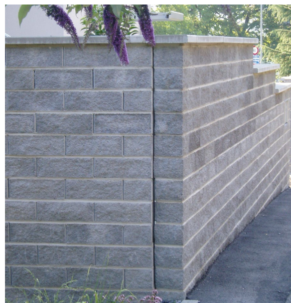
Bild 41: Dilatationsfuge (Produktneutral)
