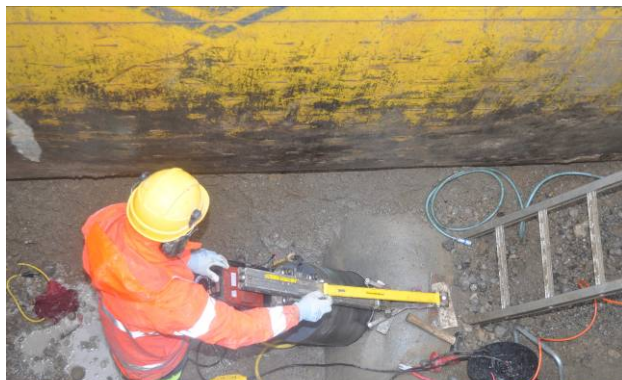
Bild 6: Korrekt montiertes Kernbohrgerät
