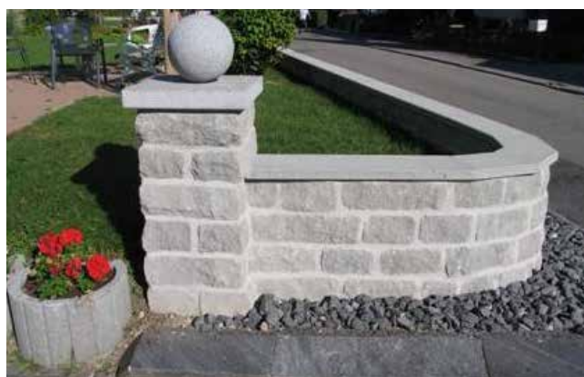
Illustration 44 : couvertines SANTURO® posées après découpe en segments
