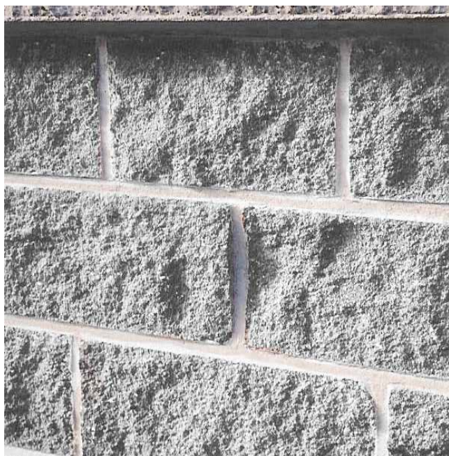
Illustration 39 : mur en briques rustiques SANTURO® avec joints de mortier
