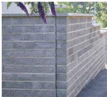
Illustration 41 : joint de dilatation (indépendant du produit)
