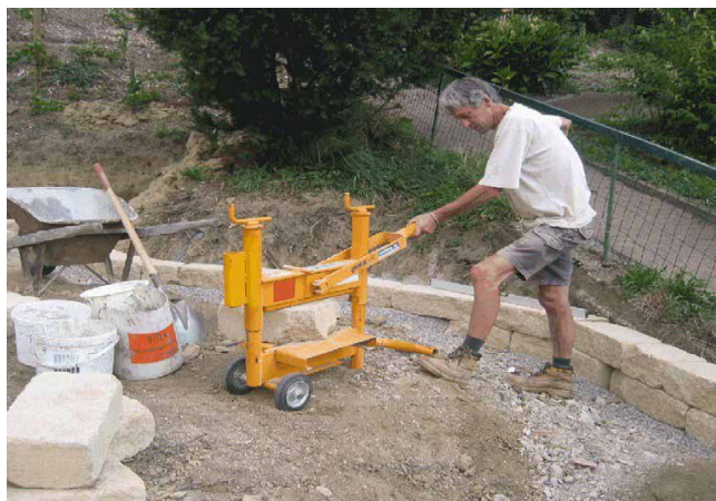
Illustration 35 : travail avec une fendeuse
