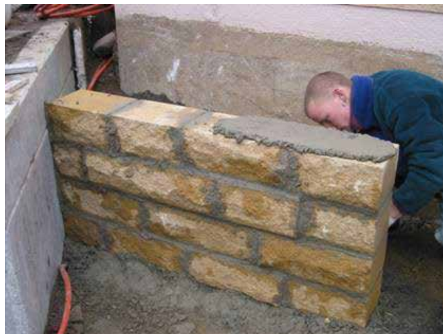
Illustration 42 : application du mortier pour les couvertines
