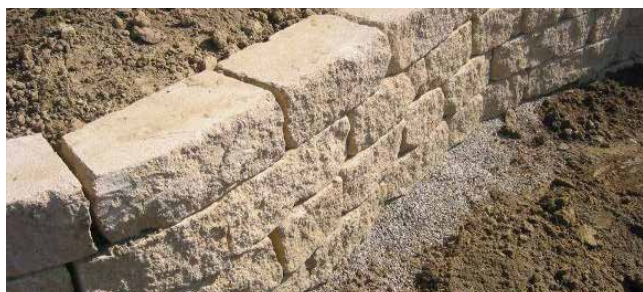
Illustration 28 : réalisation de courbes avec des briques droites
