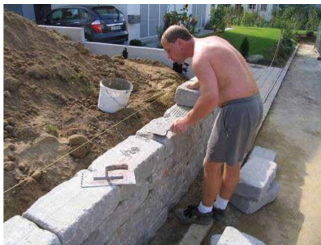
Illustration 38 : jointoiement avec du mortier
