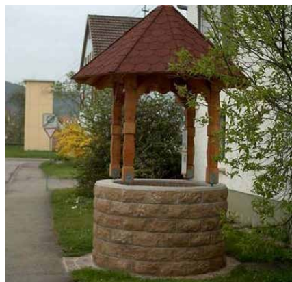
Illustration 32 : puits avec des briques biseautées SANTURO®
