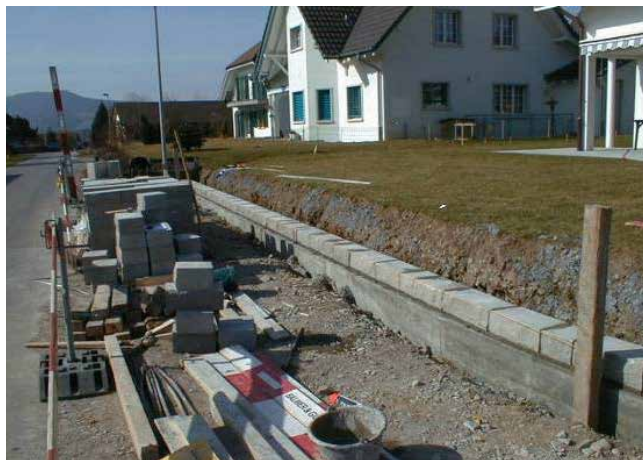
Illustration 23 : première rangée de briques posée sur des fondations en béton
