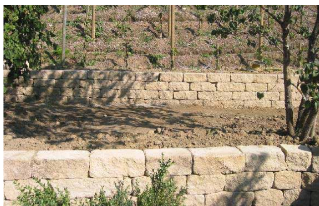
Illustration 37 : murs en pierres sèches verticaux
