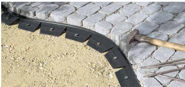
Randabschluss mit PAVE EDGE® Randschienen
