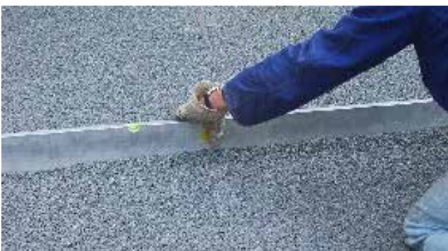
Bild 6: Bettungsschicht abziehen
