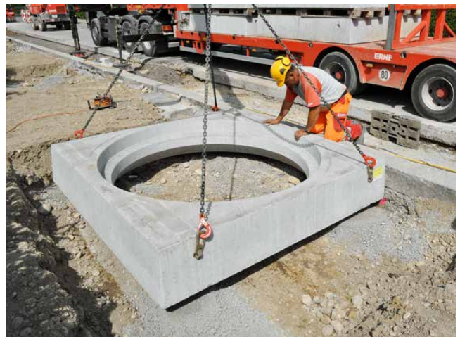
Versetzen des COPAL® QUADRO Basiselementes
