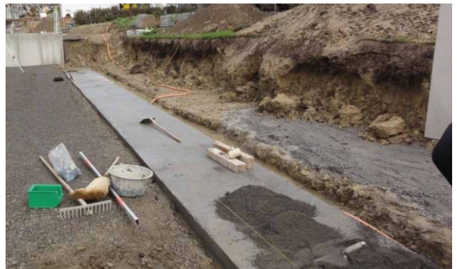
Bild 27: Erstelltes Streifenfundament
