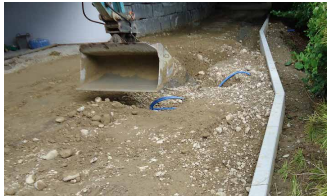
Bild 34: Lagenweises Einbringen von geeigneten Hinterfüllmaterial
