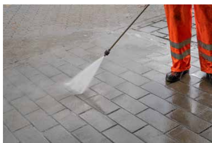
Hochdruckreiniger mit ausreichendem Abstand einsetzen.
