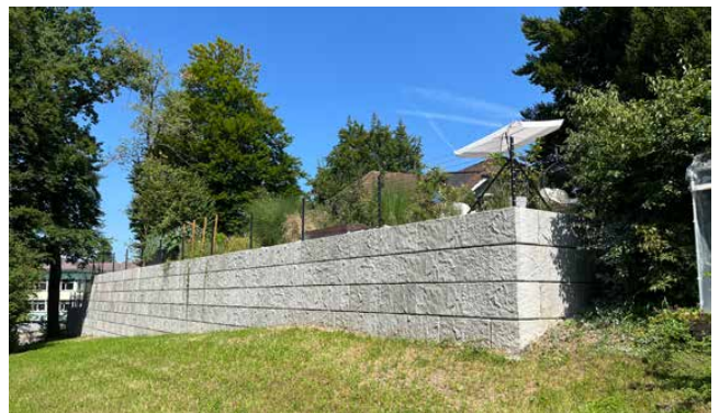
Bild 26 Geländer auf Mauerkrone
