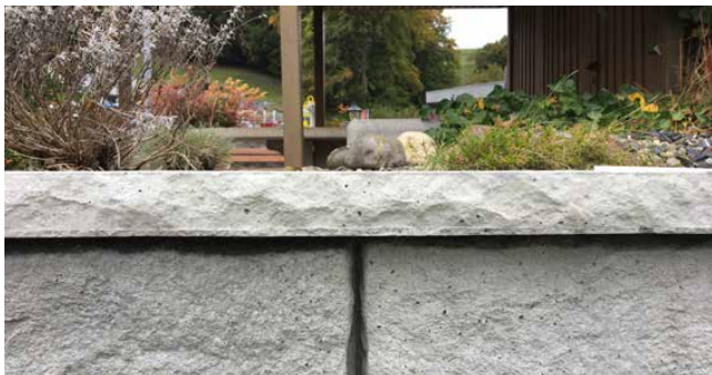
Bild 25 Abdeckplatten versetzt
