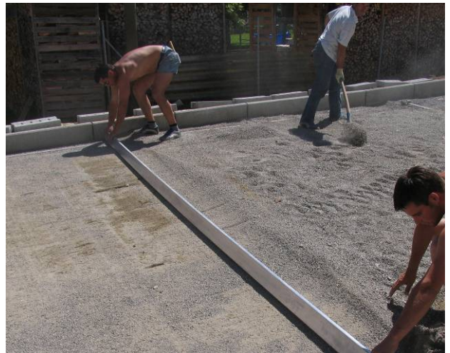
Bild 33: Abziehen der Bettungsschicht
