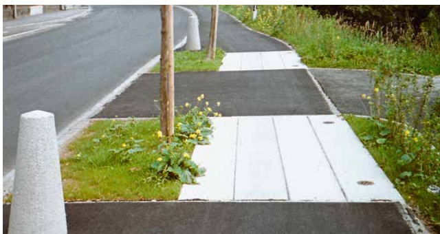
Wurzelbrücke mit Wehrsteinen als Anfahrtschutz
