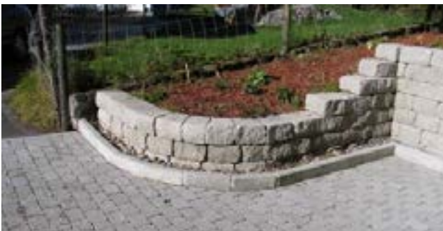
Bild 30: Maueraufbau mit SANTURO® Keilmauersteinen
