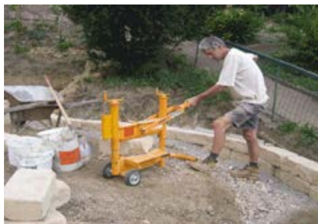
Bild 35: Arbeiten mit Steinspalter
