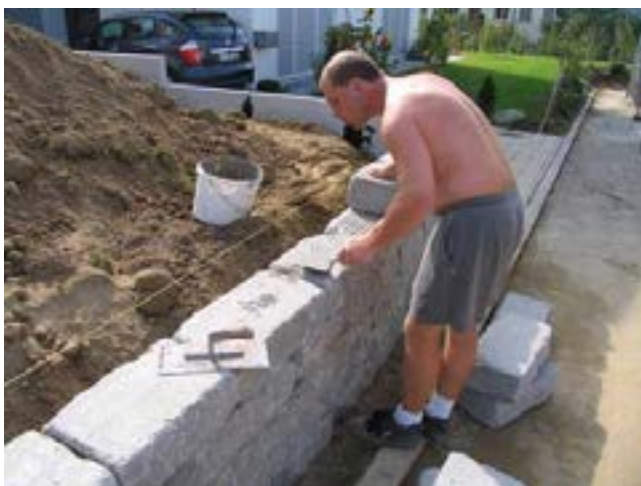
Bild 38: Mörteln der Fugen
