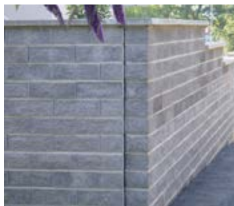
Bild 41: Dilatationsfuge (Produktneutral)
