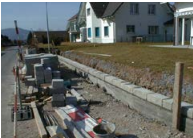
Bild 23: Versetzte erste Steinreihe in Betonfundament
