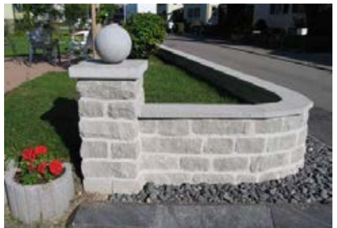
Bild 44: Versetzte SANTURO® Abdeckplatten in Segmente geschnitten
