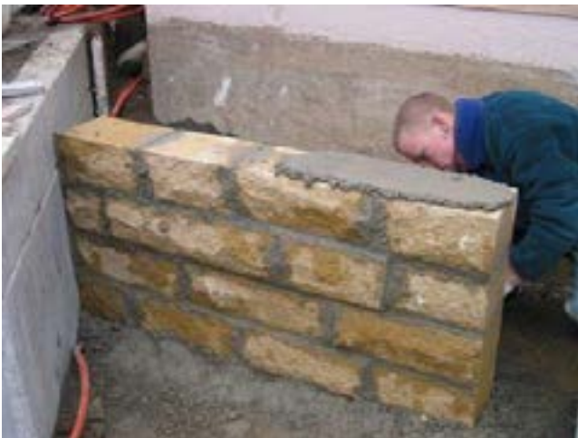
Bild 42 Aufbringen Mörtel für Abdeckplatte
