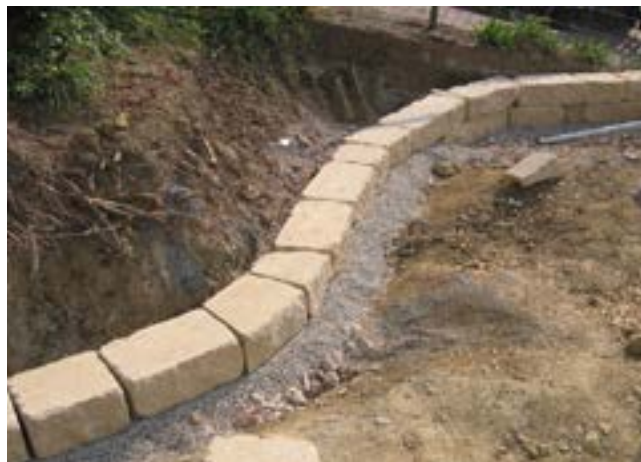
Bild 24: Versetzte erste Steinreihe in Kiesfundament
