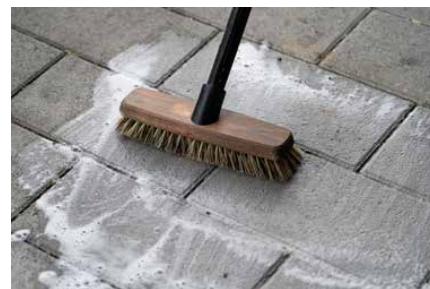
Reinigungsmittel auftragen
