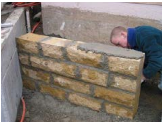
Bild 42 Aufbringen Mörtel für Abdeckplatte
