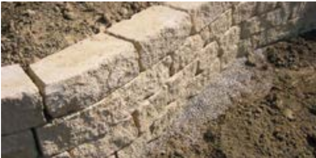
Bild 28: Kurvenbildung mit geraden Steinen
