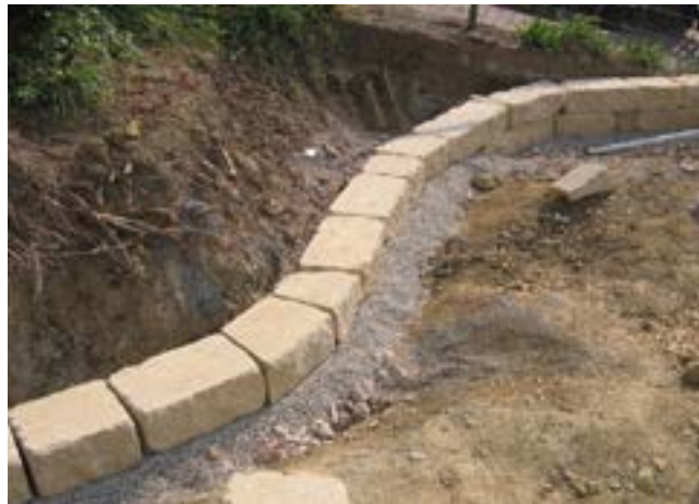
Bild 24: Versetzte erste Steinreihe in Kiesfundament
