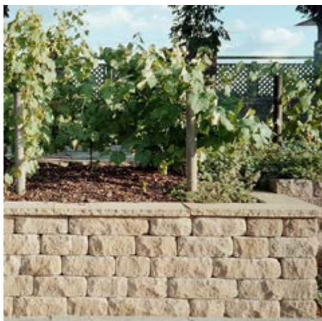
Bild 2: SANTURO® Weinbergmauer mit Abdeckplatte
