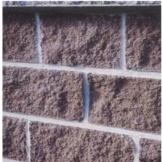
Bild 39: SANTURO® Spaltsteinmauer mit Mörtelfugen
