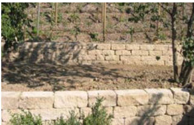
Bild 37: Senkrechte Trockenmauer
