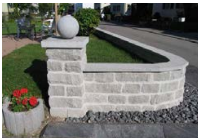
Bild 44: Versetzte SANTURO® Abdeckplatten in Segmente geschnitten
