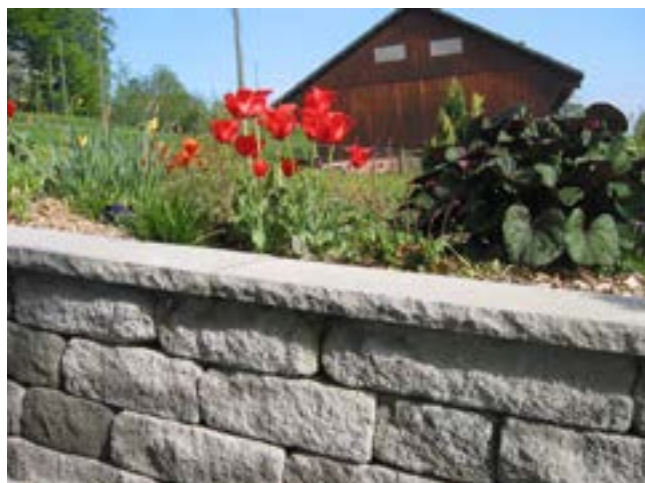
Bild 43: Versetzte SANTURO® Abdeckplatten
