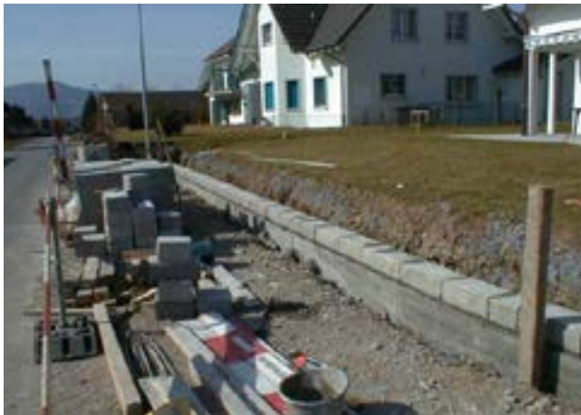
Bild 23: Versetzte erste Steinreihe in Betonfundament
