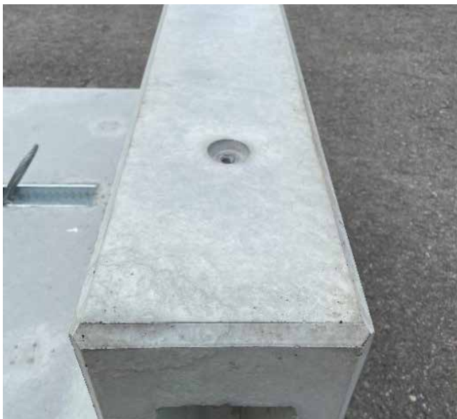
Werkseitig eingebaute Gewindehülsen
