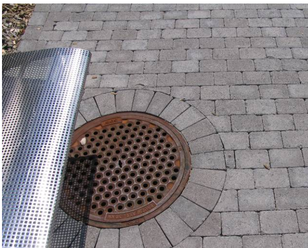
Bild 42: Anpassung bei Schachtabdeckung
