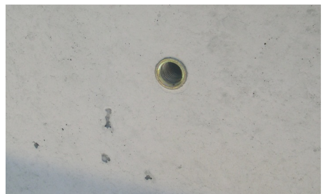
Bild 20: Werkseitig eingebaute Versetzhülsen
