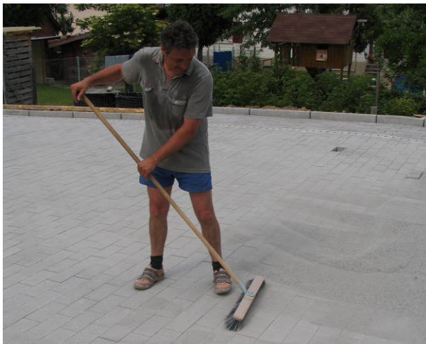
Bild 37: Einsanden der Fugen
