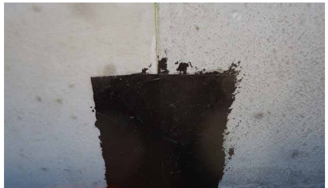
Bild 33: Abdichten der Fugen
