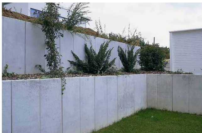
Bild 1: EXACTA® Winkelplatten als Böschungssicherung
