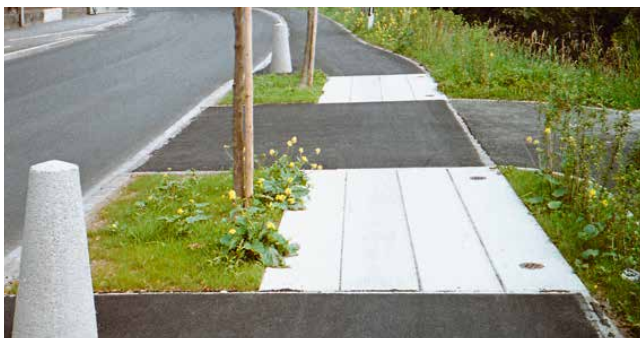
Wurzelbrücke mit Wehrsteinen als Anfahrtschutz
