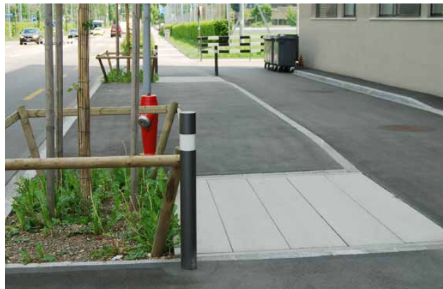
Einbau von Wurzelbrücken seitlich der Baumgrube
