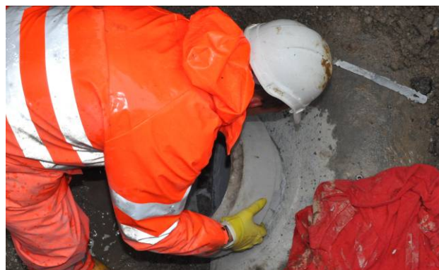
Bild 11: Klebeanschlussstück mit einer Drehbewegung einsetzen
