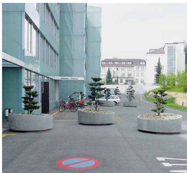
Betonrohre als Randeinfassung
