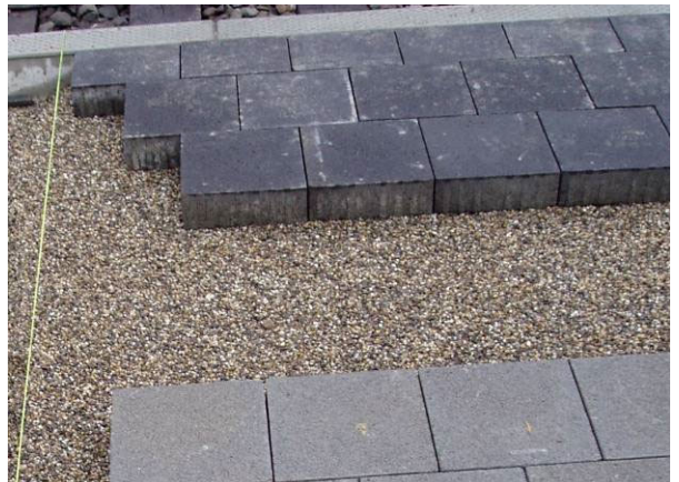
Bild 24: Eingebaute Bettungsschicht
