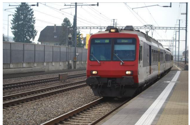
Bild 38: Bahnperron mit eingebauten CARENA® Sicherheitsliniensteinen H = 6 cm
