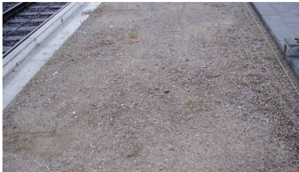
Bild 23: Eingebaute Fundationsschicht
