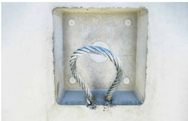
Bild 24: Werkseitig eingebaute Versetzschnäuren
