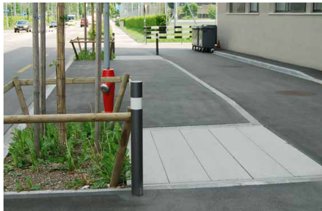
Einbau von Wurzelbrücken seitlich der Baumgrube
