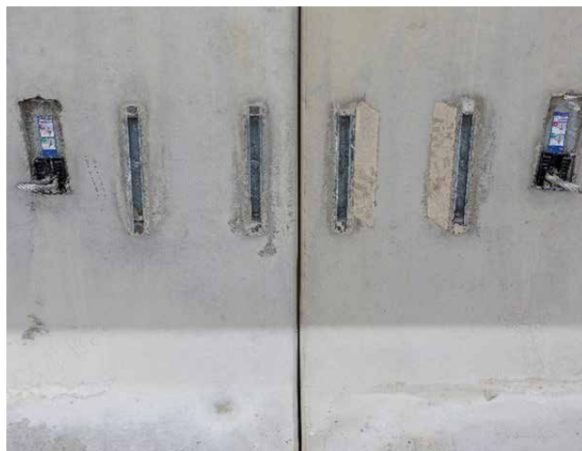
Halfenschienen als Verbindungsgrundlage
